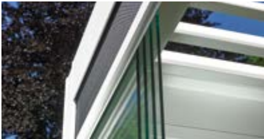
Store de protection solaire / panneau coulissant en verre
